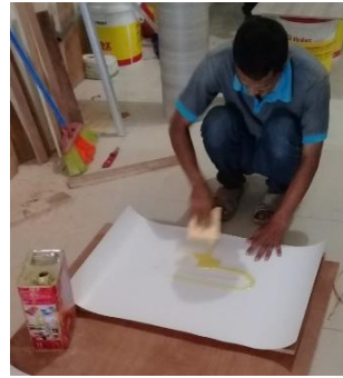
Gambar. 2. Peletakan lem pada Wallpaper
